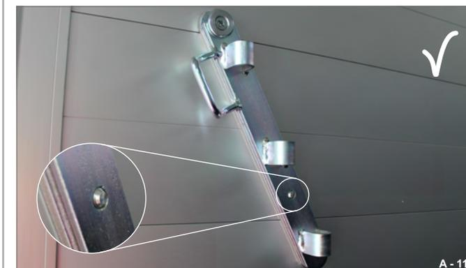
Fig. 117 Rail d'accrochage en place
