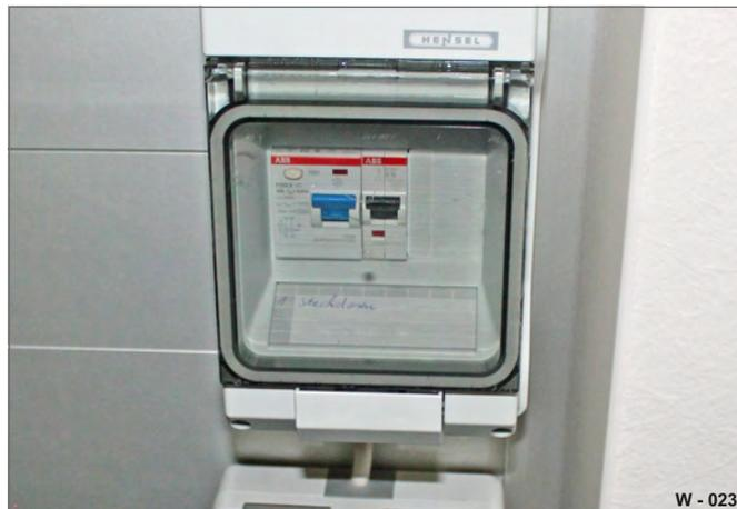
Fig. 23 Boîtier de distribution électrique à l'intérieur
