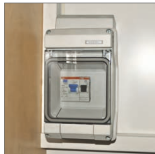
Boîte de distribution + disjoncteur + fusibles
