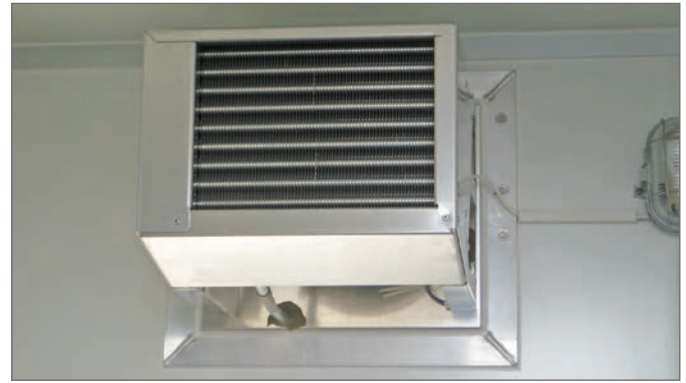
Vue intérieure HCU
