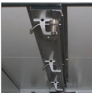
Voie tubulaire de toit
