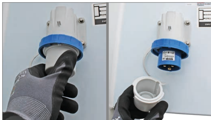
Ouverture de la borne d'alimentation électrique
