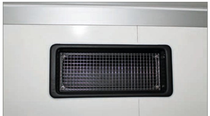
Aérateur latéral pour la ventilation mécanique
