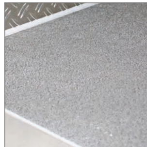
Isolation de sol
