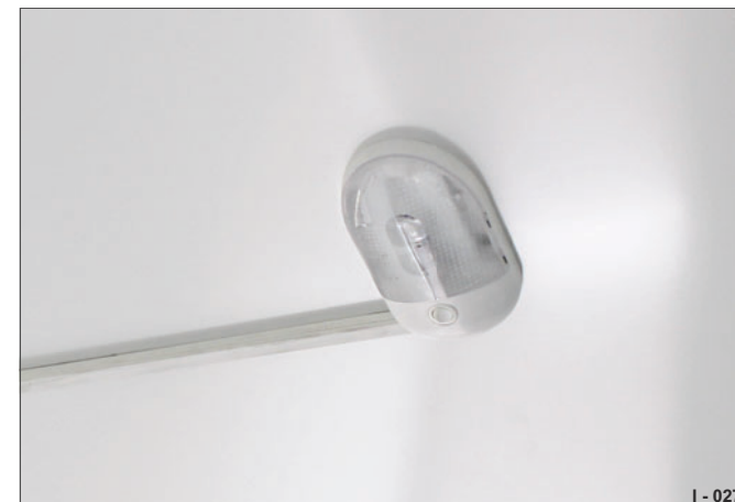
Fig. 21 Éclairage intérieur 12 V
