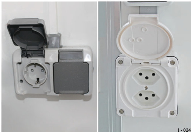
Fig. 18 Prise de terre double / Suisse
