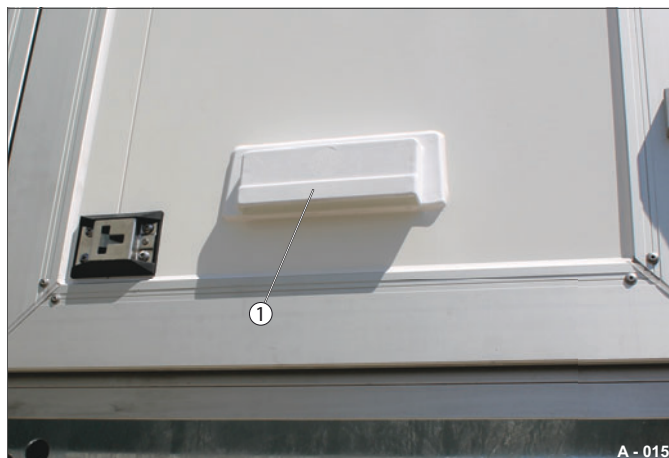
Fig. 10 Fente d'aération vue depuis l'extérieur
