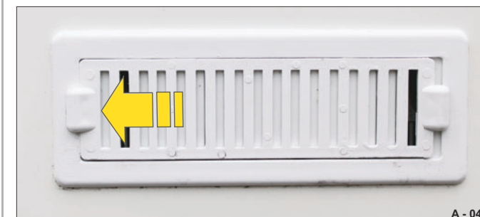
Fig. 13 Fente d'aération fermée
