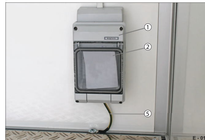
Fig. 10 Boîtier de distribution
