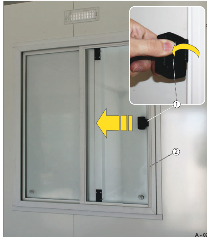
Fig. 5 Ouverture des fenêtres coulissantes
