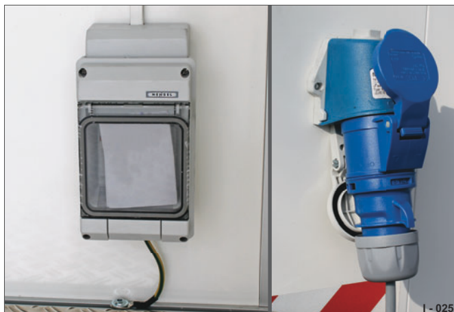
Fig. 19 Alimentation électrique 230 V
