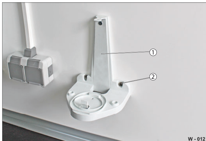
Fig. 7 Contrôle de la fixation du radiateur à air pulsé
