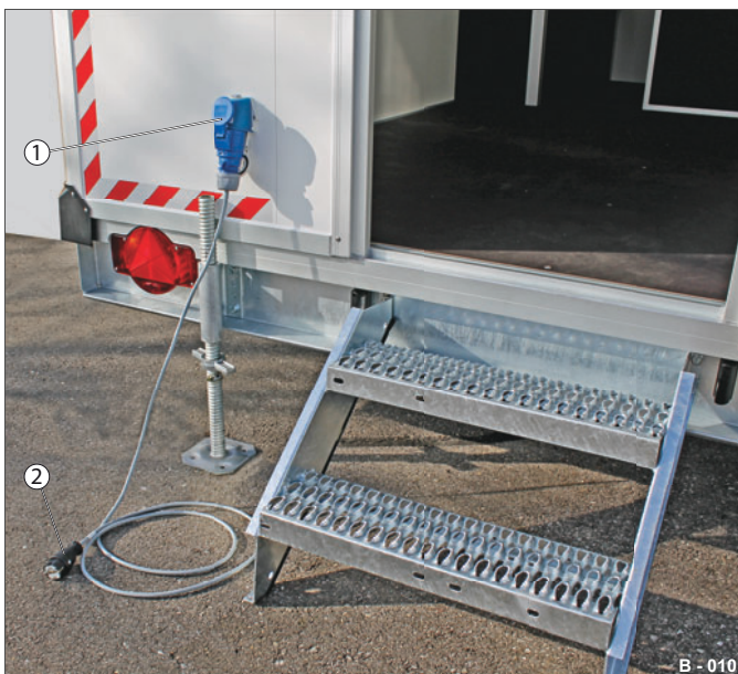
Fig. 11 Alimentation électrique externe 230 V AC
