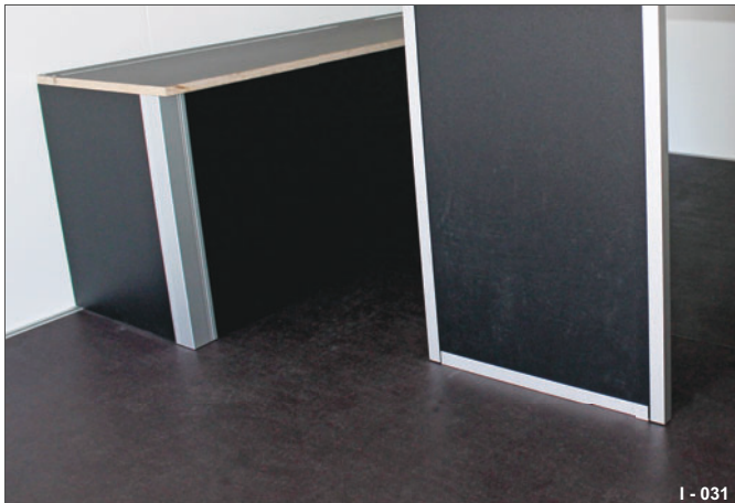
Fig. 3 Sol (18 mm d'épaisseur) constitué de plaques de bois multicouches
