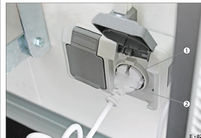
Fig. 20 Radiateur à air pulsé branché
