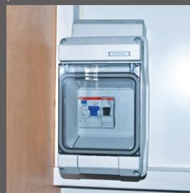
Boîtier de raccordement avec disjoncteur différentiel et fusible (16 A)
