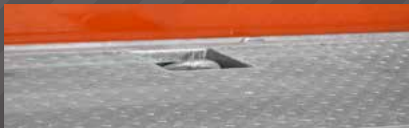
Geribde staalplaat op vloer
