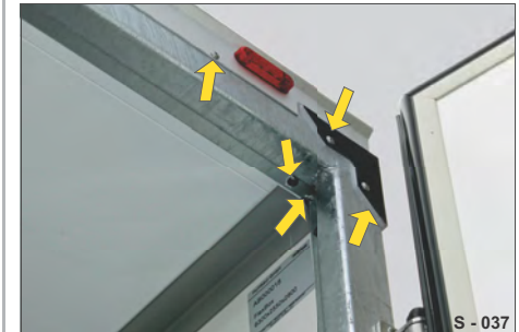
Abb. 39 Eckverbindung außen
