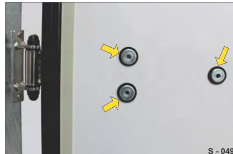
Abb. 52 Türscharniere-Befestigung innen
