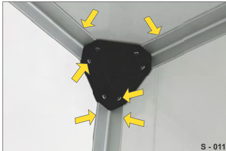
Abb. 17 Eckverbindung / Einfassprofile oben
