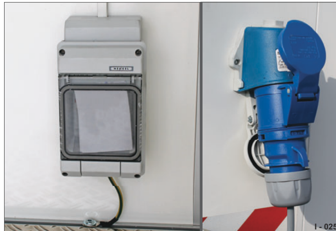
Abb. 19 230 V Stromversorgung
