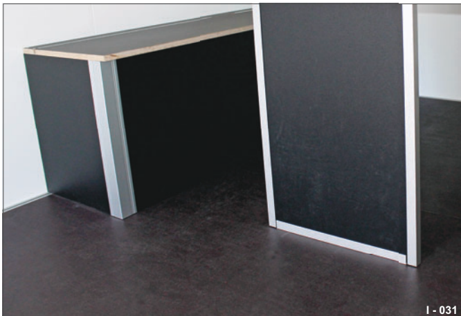
Abb. 3 Boden (18 mm stark) aus Mehrschichtholzplatten
