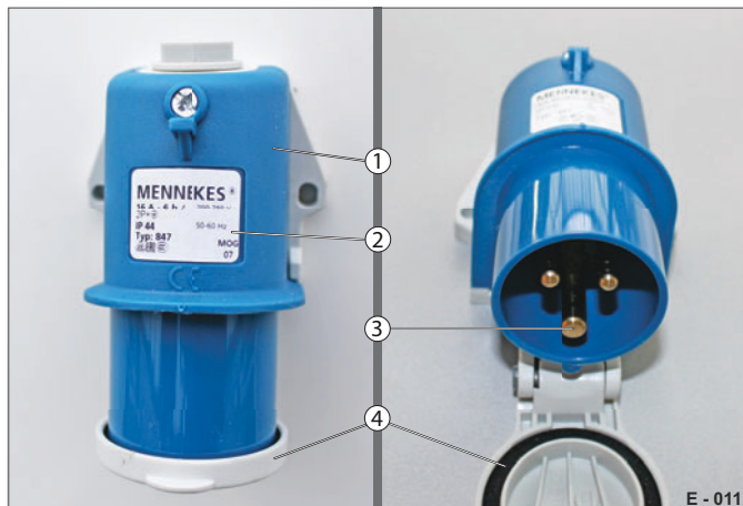
Abb. 11 Netzanschluss (Stirnwand außen)
